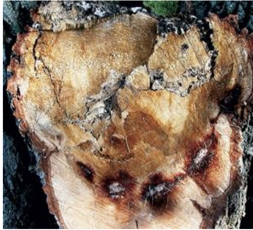
Figura 4. Madera afectada por un hongo de pudrición blanda
