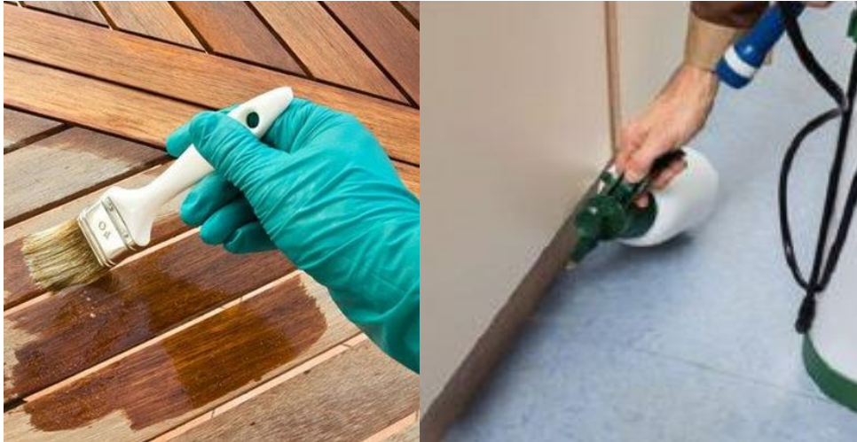
Figura 22. Representación de las distintas aplicaciones en superficie de preservantes. Aplicación a brocha (izquierda, adaptada de la fuente [88]) y pulverización (derecha, adaptada de la fuente [89]).
